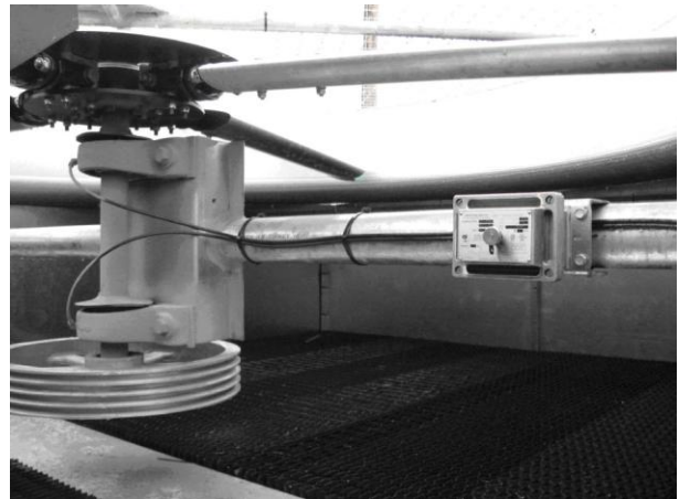
Рисунок В. Типичная установка 5550 на опоре вентилятора
